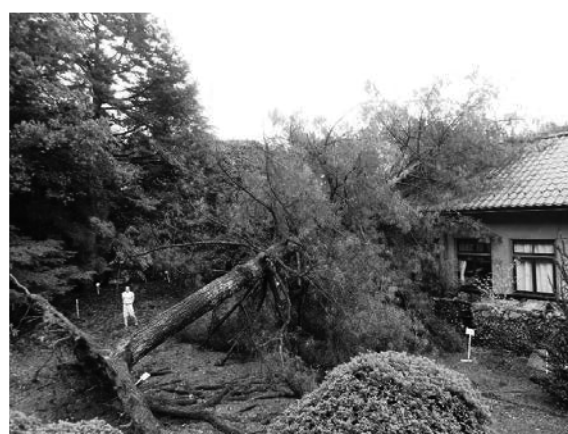
台風被害（講義室屋根破損）
