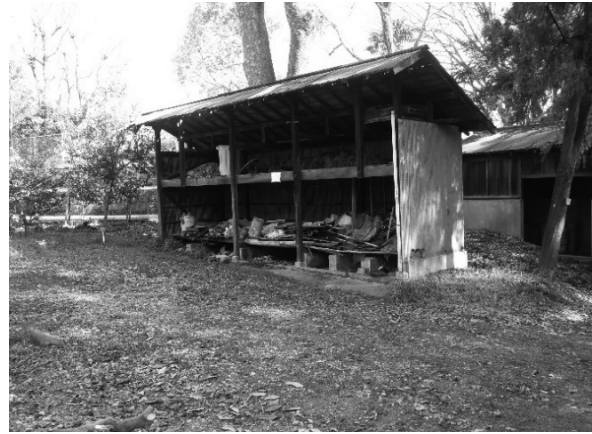
堆肥舎（手前）・堆肥溜舎（奥）解体前
