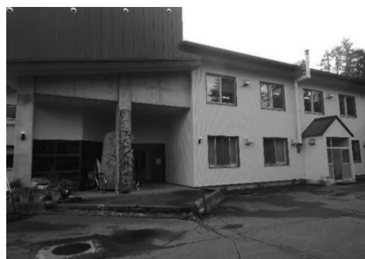
外壁塗装を塗り替えた研究林事務所
