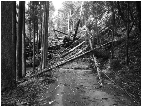
台風 21 号による事務所前町道の崩落
