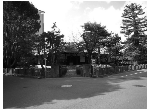
危険木処理後
