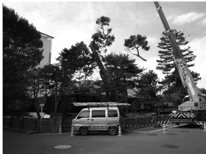
危険木処理中
