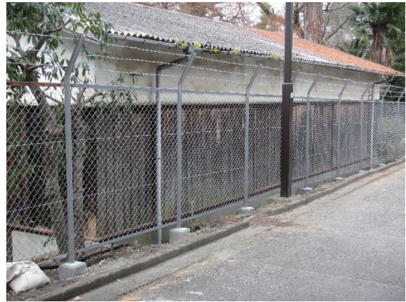
写真：ネットフェンス改修後
