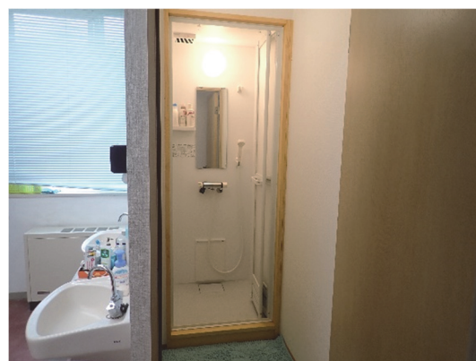
増設した女性用シャワー室
