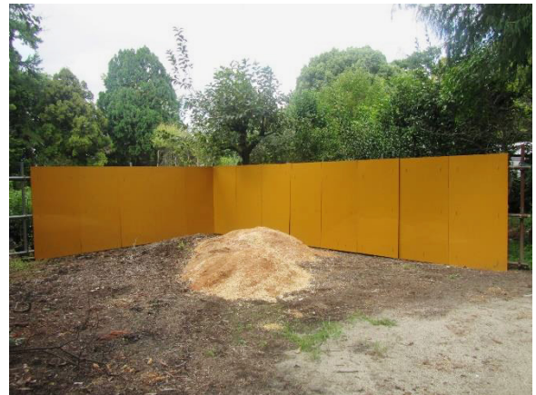
チップ集積場改修完了
