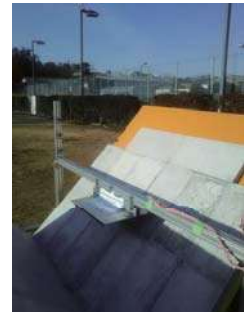
反射板素材 コンパネ+コンクリート平板
