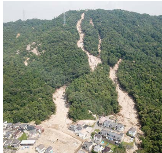
図1 熊野町川角で発生した土石流の流動域
