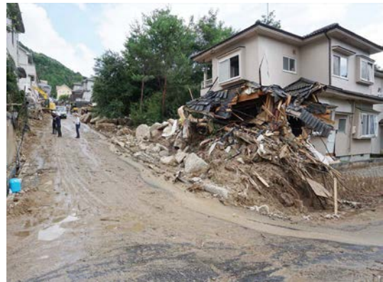
図2 熊野町川角で被災した家屋
