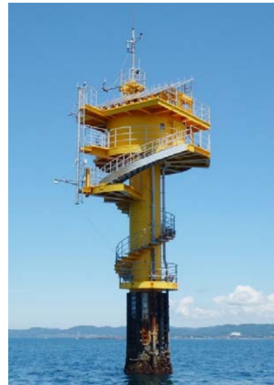
写真1 田辺中島高潮観測塔
