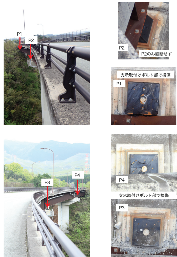
写真-6 大切畑大橋のゴム支承の破断と桁逸脱
