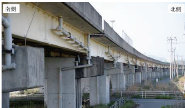
写真-16 木山川橋を木山川から北側へ望む (4月15日撮影)
