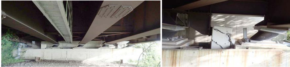
(i) 橋台部全景
