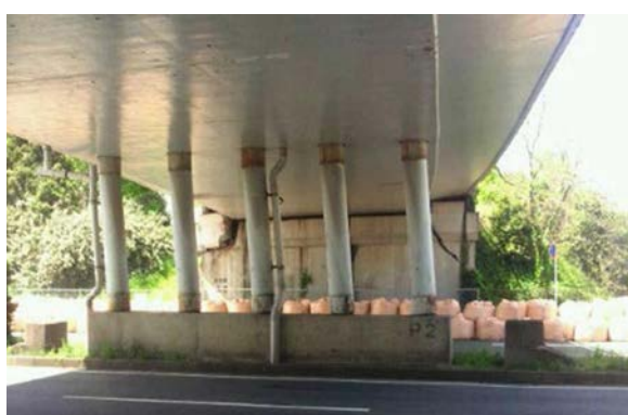
(i) 橋台部全景
