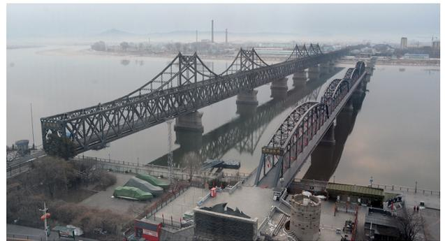
図-15 鴨綠江橋梁（左が複斜材型トラス橋梁, 右は旧橋である単純トラス橋梁, 撮影：高橋, 2018年3月）
