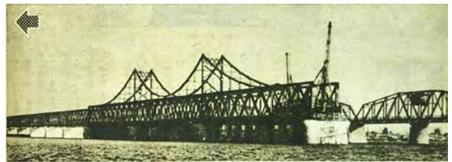
図-20 第一主径間の初応力調整を終えて最後の据付完了時<sup>45)</sup> (推定撮影年:1942年)
