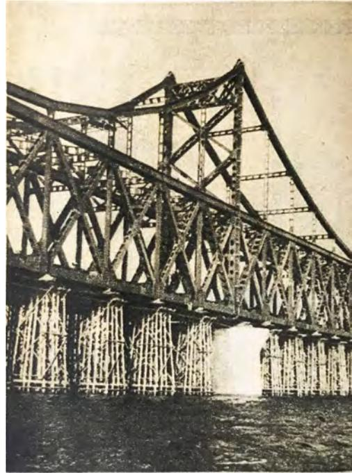
図-19 各格点位置に足場が建設された初応力調整の状況<sup>45)</sup> (推定撮影年:1942年)
