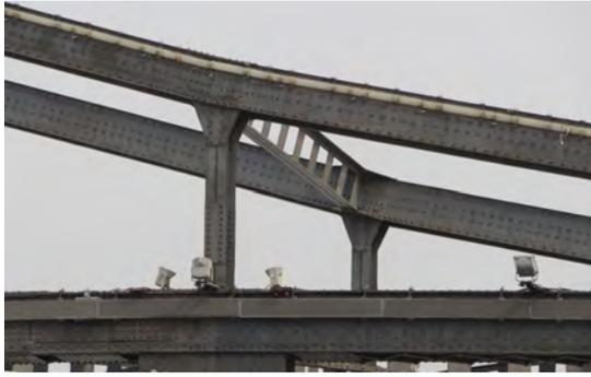
図-18 鴨緑江橋梁の吊弦材, 上弦材, 鉛直材 (撮影:高橋, 2018年3月)
