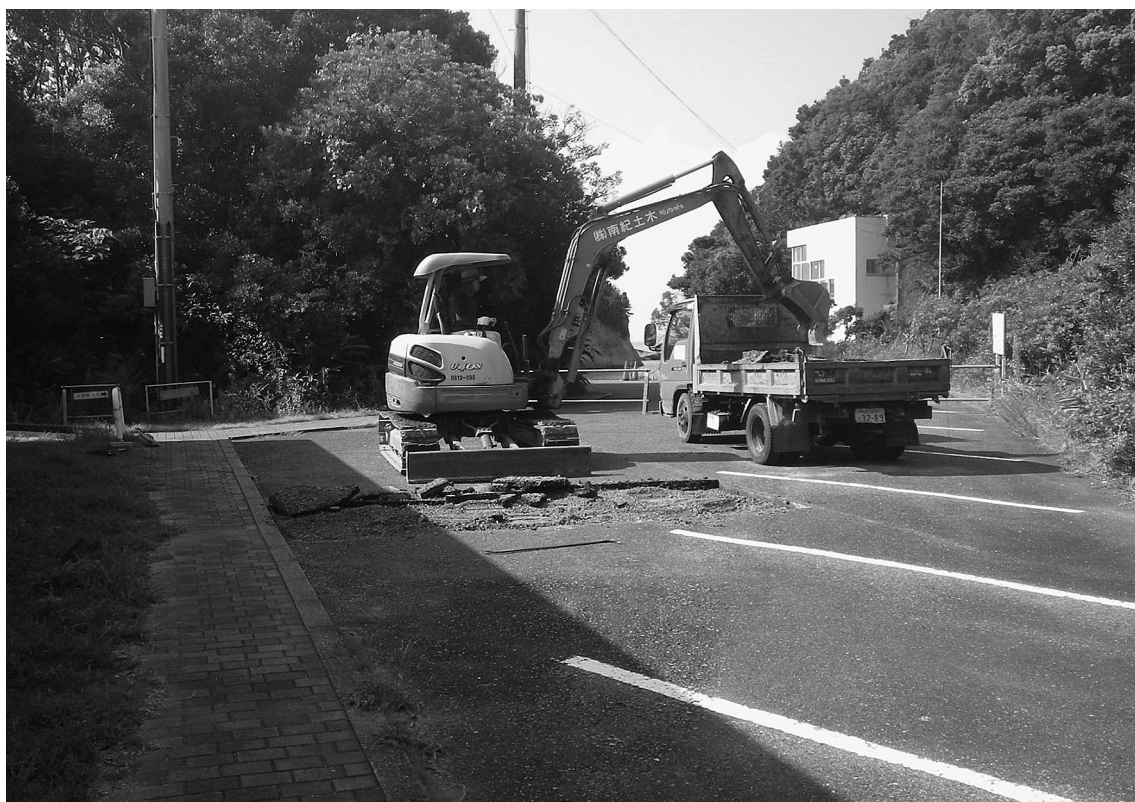
1 C区表土除去作業状況（北から）
