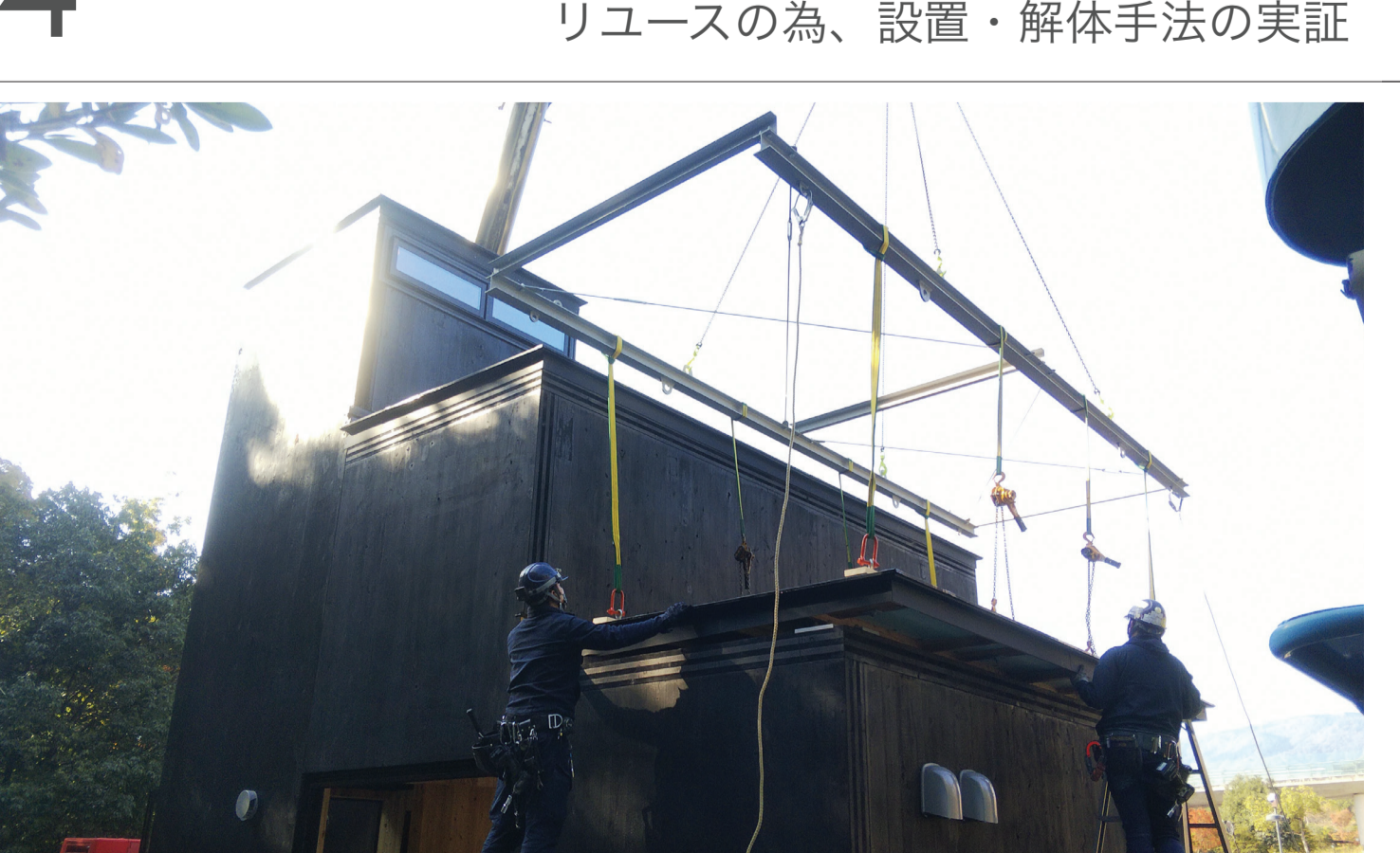
一度京都大学に設置したものを解体し、当初予定地へ建設することで実証 / 総建工業CLT工場第2加工工場の休務所兼事務所 (2021-2022) 林野庁 CLTを活用した建築物等実証事業2022 採択事業 リユースの為、設置・解体手法の実証
