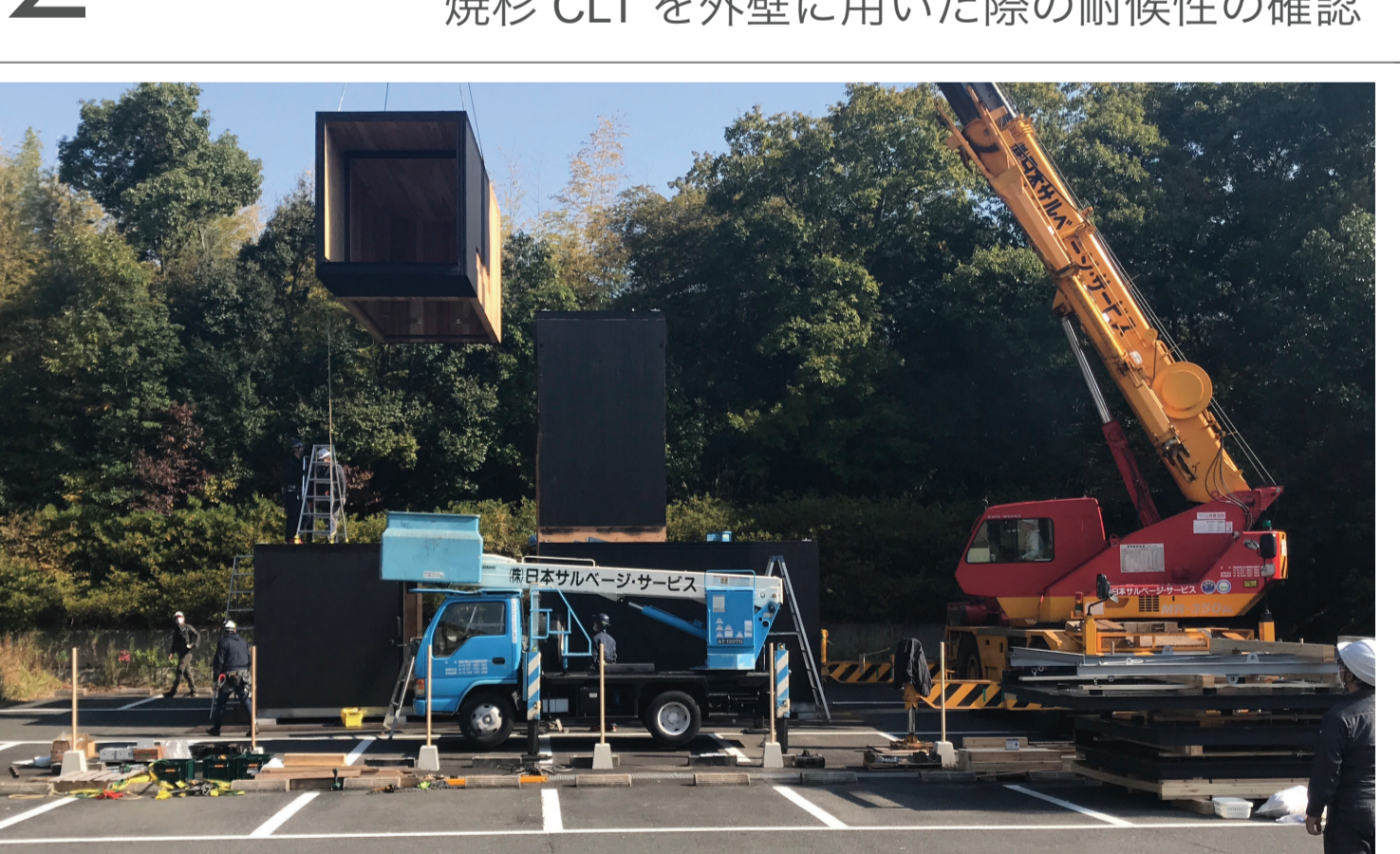
ユニット運送及び吊り込みの様子（京都大学桂キャンパスにおける建設実験） / 総建工業CLT工場第2加工工場の休務所兼事務所 (2021-2022) 林野庁 CLTを活用した建築物等実証事業2022 採択事業 ユニット運送及び吊り込み方法、吊り込み治具の実証
