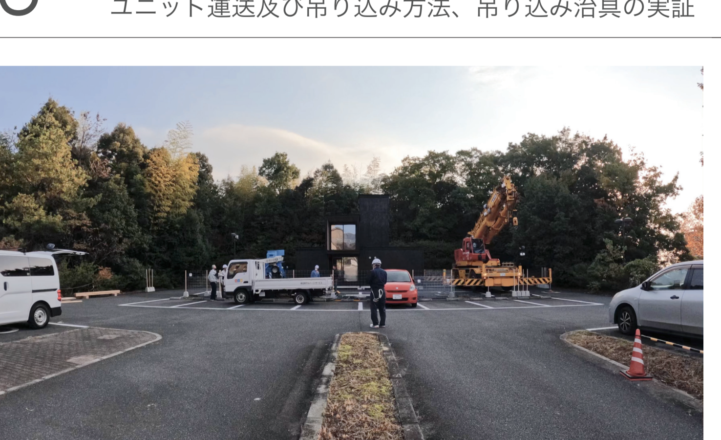
一度京都大学に設置したものを解体し、当初予定地へ建設することで実証 / 総建工業CLT工場第2加工工場の休務所兼事務所 (2021-2022) 林野庁 CLTを活用した建築物等実証事業2022 採択事業 リユースの為、設置・解体手法の実証
