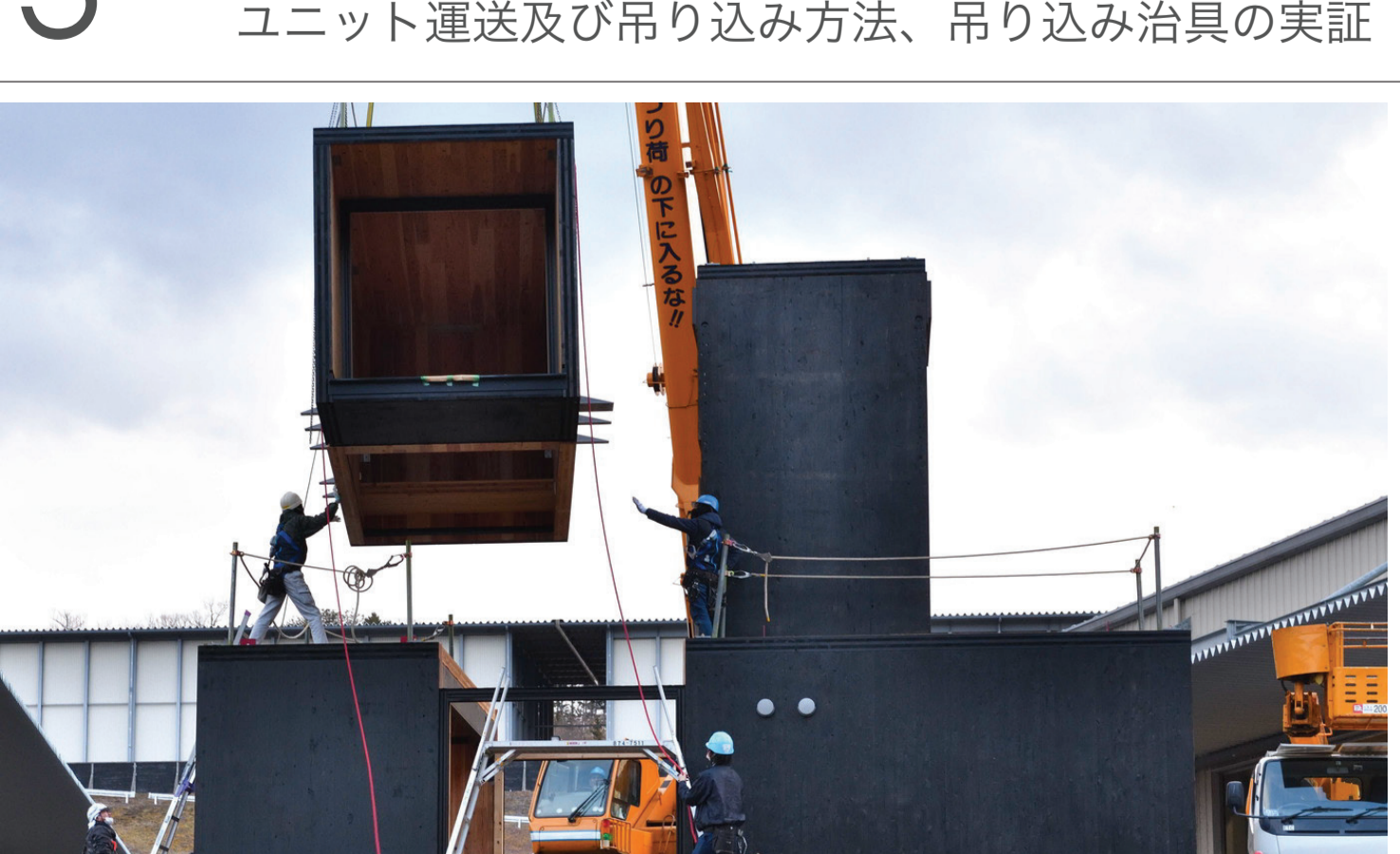
一度京都大学に設置したものを解体し、当初予定地へ建設することで実証 / 総建工業CLT工場第2加工工場の休務所兼事務所 (2021-2022) 林野庁 CLTを活用した建築物等実証事業2022 採択事業 リユースの為、設置・解体手法の実証
