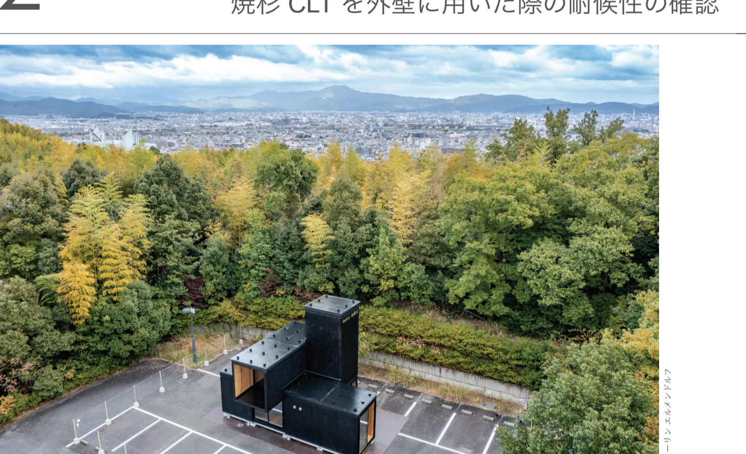
ユニット運送及び吊り込みの様子（京都大学桂キャンパスにおける建設実験） / 総建工業CLT工場第2加工工場の休務所兼事務所 (2021-2022) 林野庁 CLTを活用した建築物等実証事業2022 採択事業 ユニット運送及び吊り込み方法、吊り込み治具の実証
