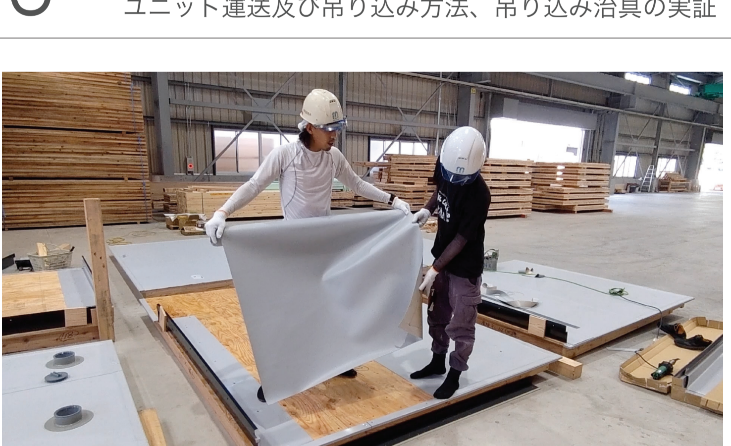
屋根のユニット化により、防水工事のプレファブリケーション化を図る / 総建工業CLT工場第2加工工場の休務所兼事務所 (2021-2022) 林野庁 CLTを活用した建築物等実証事業2022 採択事業 ユニット運送及び吊り込み方法、吊り込み治具の実証
