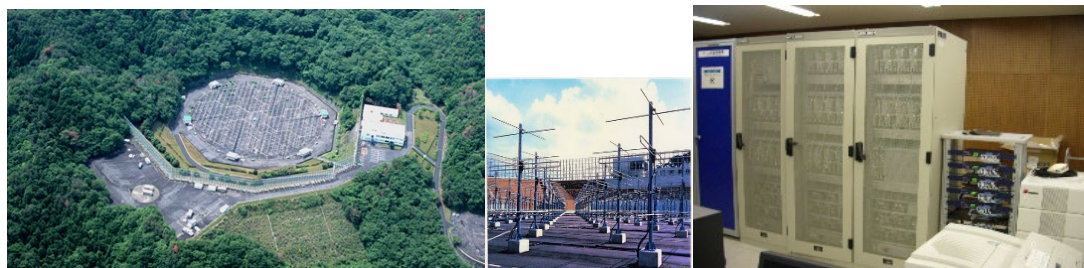
図 1: 信楽 MU 観測所全景（左）と MU レーダーアンテナアレイ（中央）、MU レーダー観測強化システムで導入された超多チャンネルデジタル受信機（右）。
