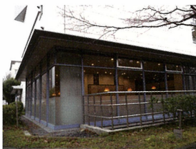
環 on 外観（人環棟東）
