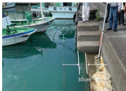
写真-6 佐喜浜漁港の岸壁上部ブロックの突き出し
