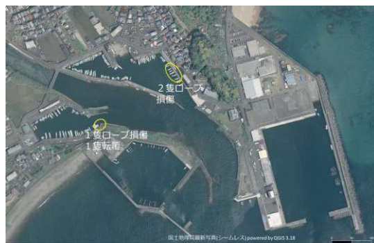
図-8 佐賀漁港における被害箇所
