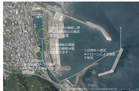
図-4 佐喜浜漁港の被害概況
