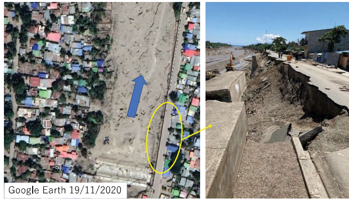
写真8 A-pointの被災状況（Comoro川）（4月12日撮影）
