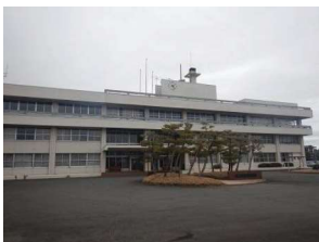
写真 13 登米市米山 総合支所
