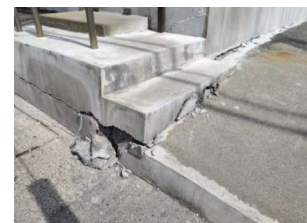
写真 24 基礎の被害
