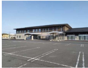
写真1 栗原市築館 総合支所
