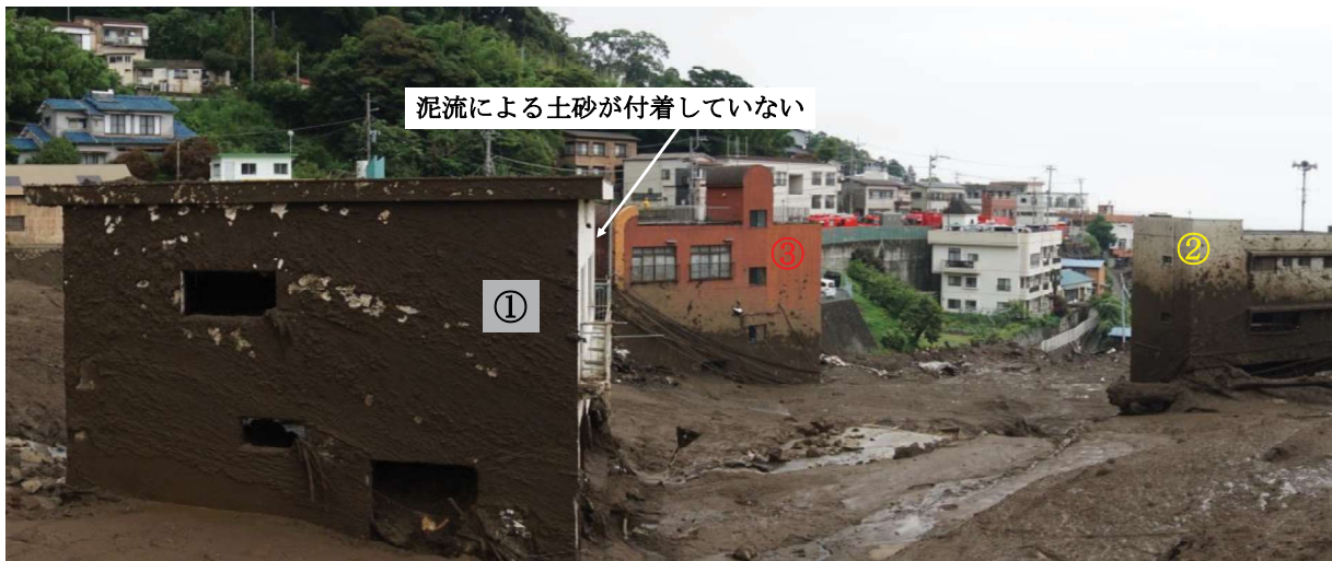
図-7 泥流流動域に残存した建物
