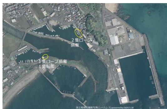
図-8 佐賀漁港における被害箇所
