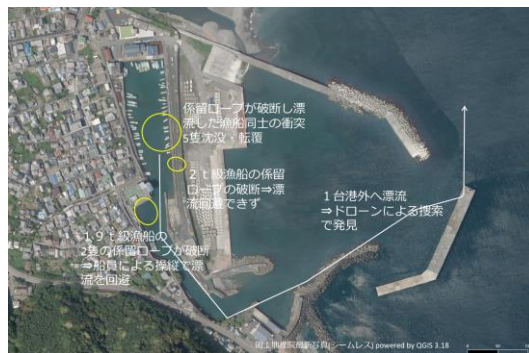
図-4 佐喜浜漁港の被害概況
