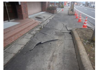
写真8 舗装の被害
