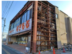
写真3 外壁の被害
