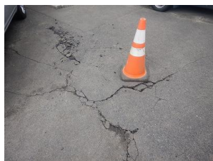
写真 31 舗装の被害
