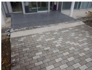
写真11 舗装の被害
