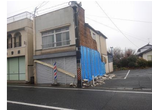
写真 56 外壁の被害
