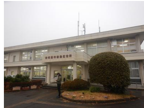
写真 53 南相馬市鹿島 区役所
