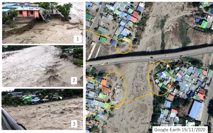
写真10 B-pointの被災状況（Comoro川）（4月4日撮影）
