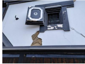
写真19 外壁の被害
