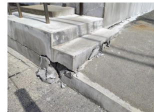
写真24 基礎の被害
