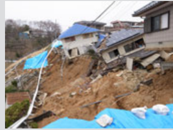
2011年東北地方太平洋沖地震によって発生した地すべりと住宅の被害 Collapse of housing lot by landslide induced by the 2011 Tohoku Earthquake
