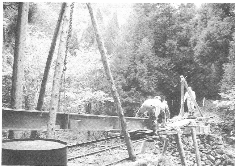
写真-3 主桁をつり上げ対岸に架ける
