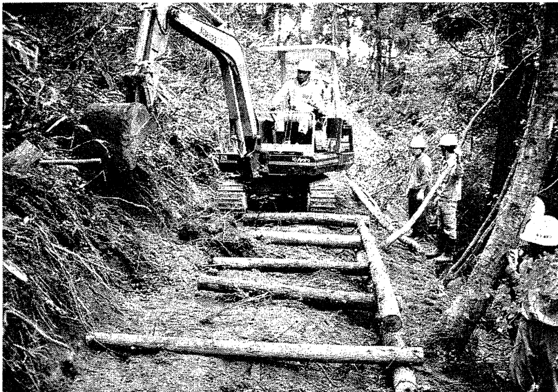
横木を入れ法面の土を入れる
