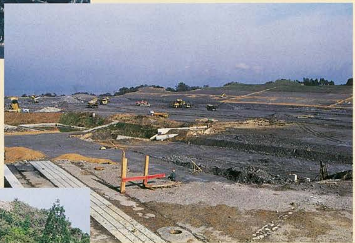
着々と進む空港建設（平成6月12月）
