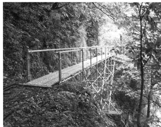
タケヤクリ歩道橋
