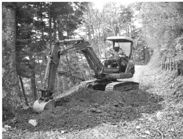
林道手入（横断溝設置）
