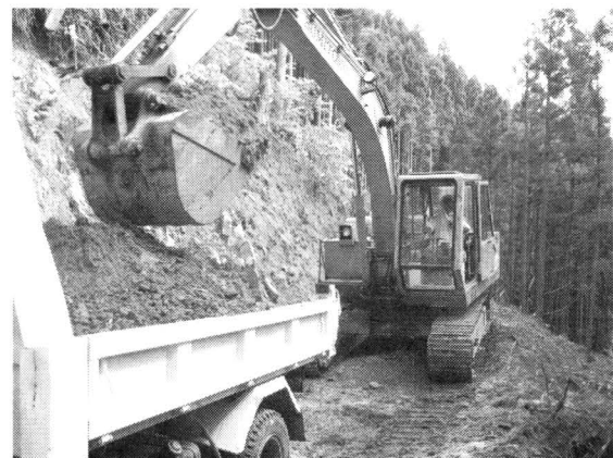
林道新設 (土砂積み込み)
