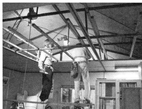
事務所天井修理
