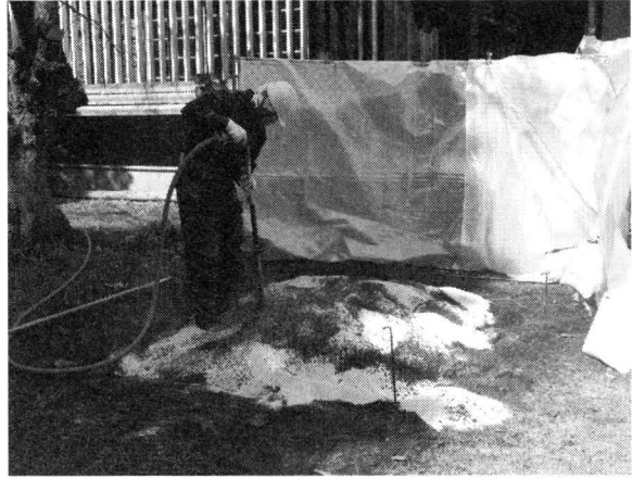
エアコンプレッサーによる土壤改良作業
