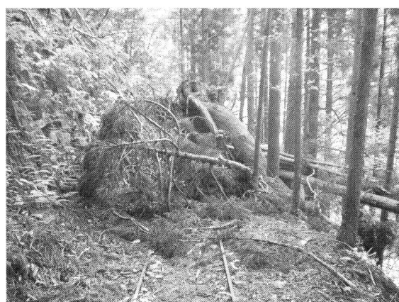
軌道敷き風倒木
