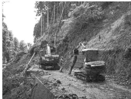
台風被害木処理 (7月)
