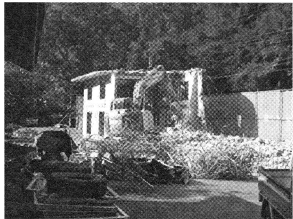
5号職員宿舎の解体撤去
