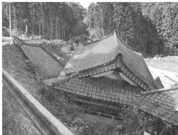
図 20 倒壊した住宅
