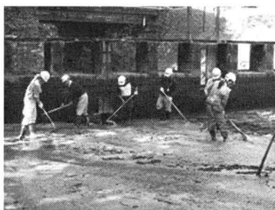
写真5 土砂排出作業
