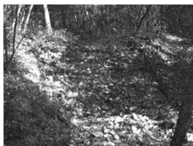
写真8 堰堤工（石積）
