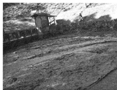
写真6 土砂排出後の堰堤
