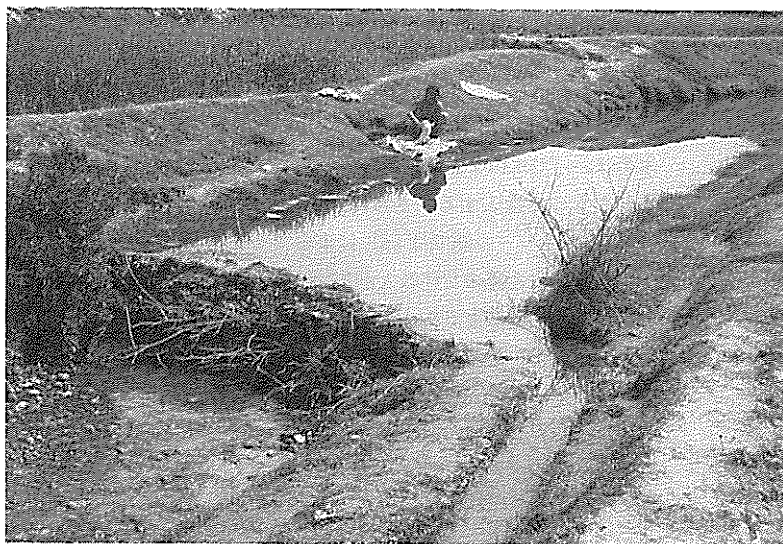
写真3 小川につくられた堰と取水口(右側)
