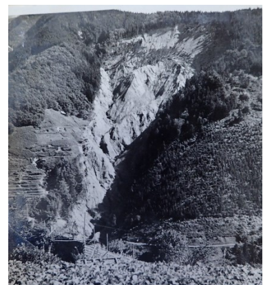
H: Kukidani landslide
