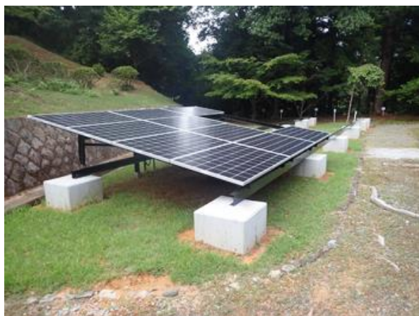
太陽光発電パネル設置 3kw分
