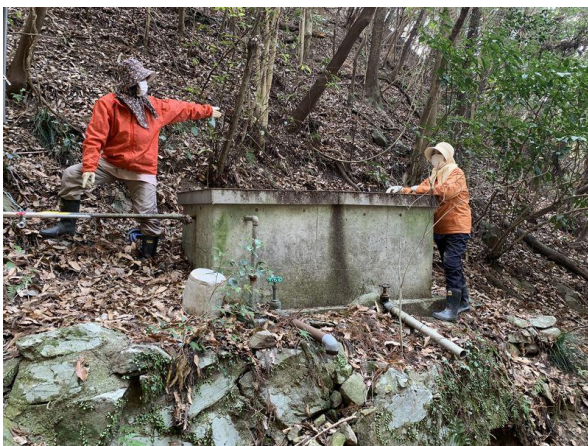
(給水配管施設の補修)
