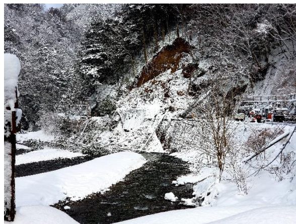
府道 38 号線崩落災害
