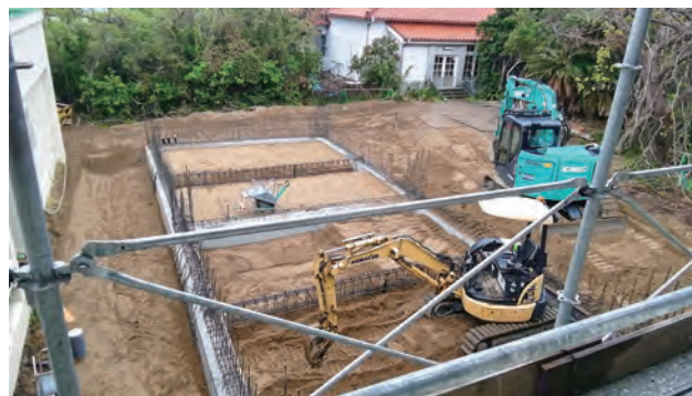
新研究棟の基礎工事
