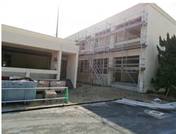
改修中の研究棟
