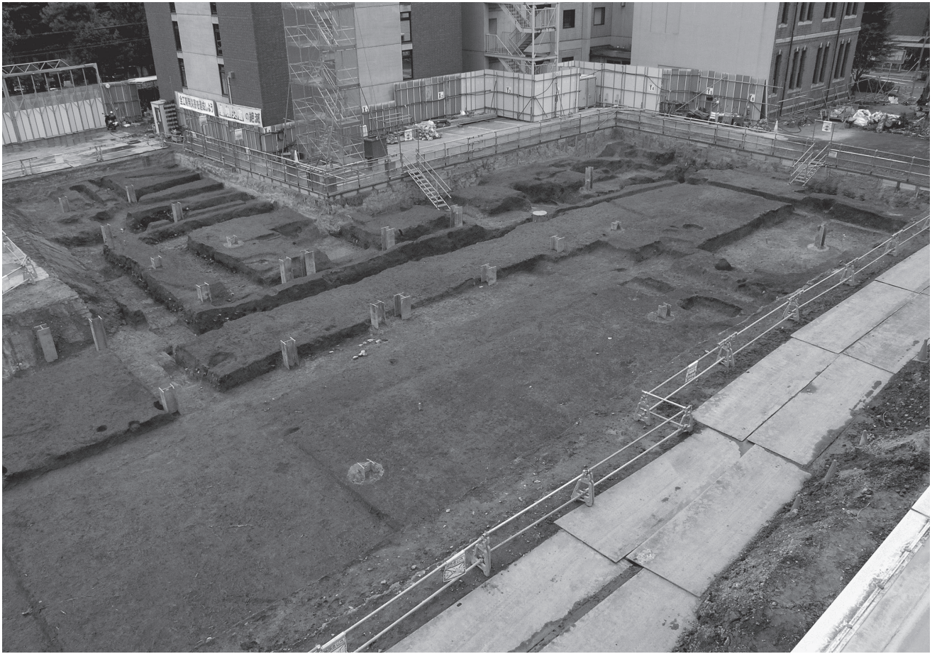
1 表土・攪乱除去後の全景（北東から）
