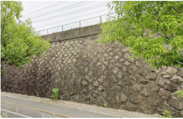
図2 鉄道盛土の石積み壁
