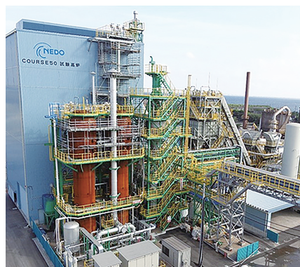
図1：水素還元方式の高炉（君津製鉄所 試験高炉，出典①）
