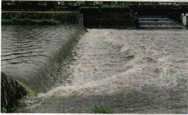
図-12 小出水時の落差工近傍の流れの様子 (丸太町橋下流)
