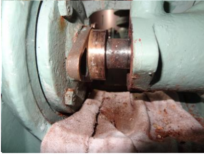
作業風景:手直し
