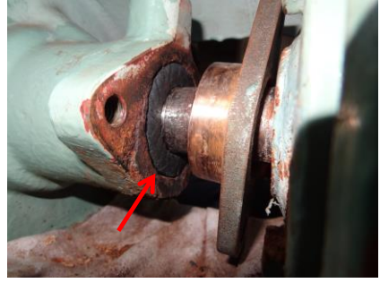
作業風景:新パッキンの取り付け
