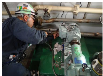
作業風景:センターリング
