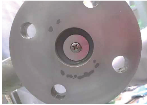
写真8 SP1系アルミフランジ補修後
