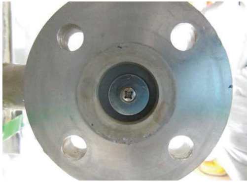
写真7 SP1系アルミフランジ補修前
