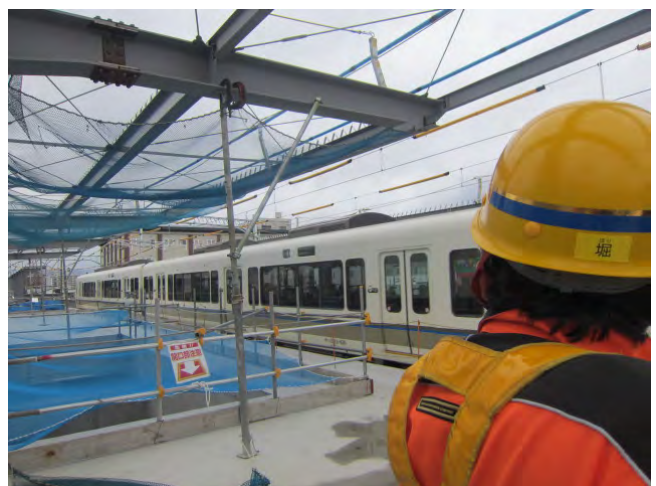
図5 新駅工事現場ホームを通過する電車
