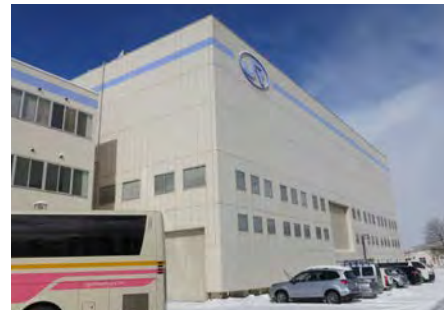
写真-1 風洞技術センターの外観
