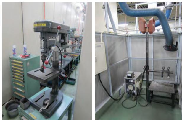
図 6 ボール盤（左）、溶接設備（右）
