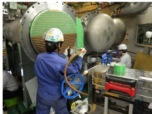
図.2 渦流探傷検査作業風景
