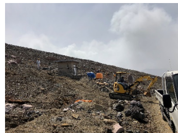
図5 修理途中の観測室
