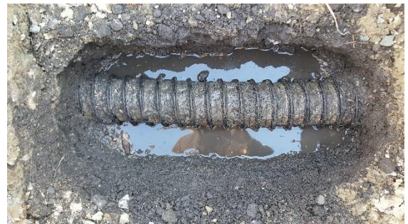
図2. 露にした既設暗渠管
