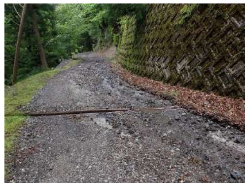
図 2 鋼製 U 字溝
