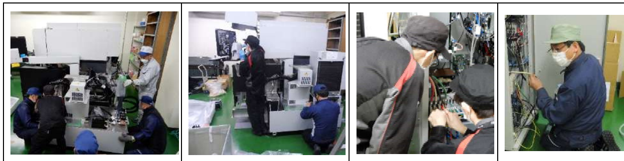
図2 組み立て、配線作業
