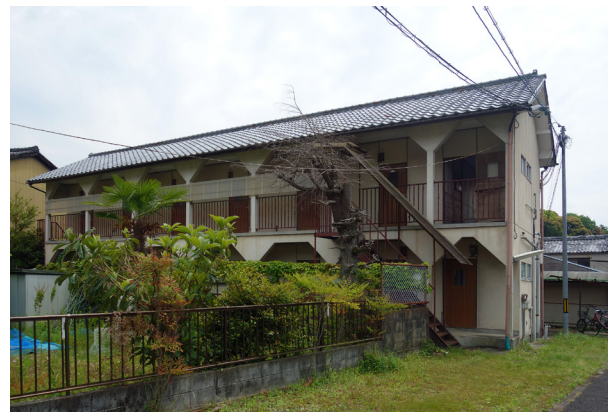
元学生アパートの外観 (改修前)
