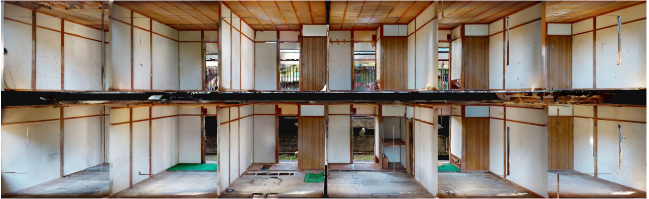
改修前のアパート VR 撮影
