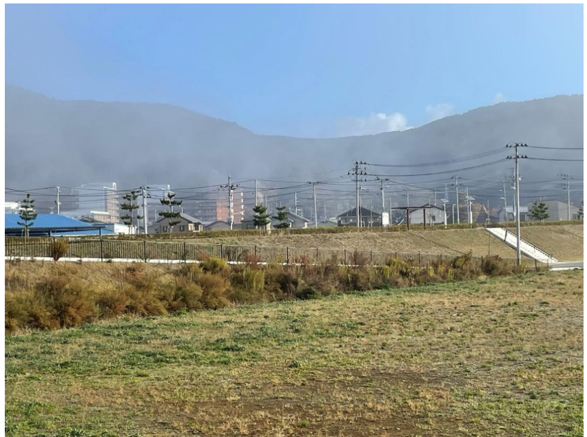
「災害危険区域」盛土までが災害危険区域
