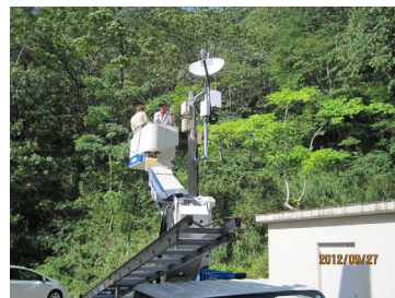
衛星通信機器の設置
