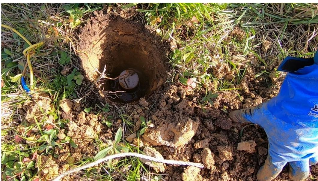
図5 電位測定用電極の埋設時の様子
