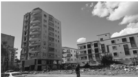
写真-1 崩壊建物解体と地震に耐えた建物の事例
