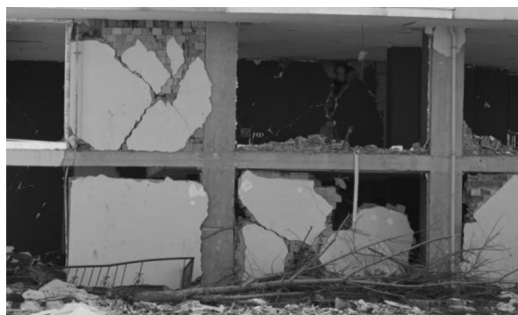
写真-2 地震に耐えた建物の1・2階の壁
